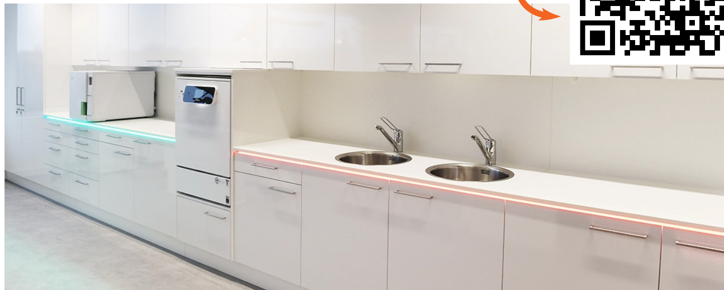
Bovenstaande sterilisatie-ruimte is verzorgd in opdracht van ROC Amsterdam.
